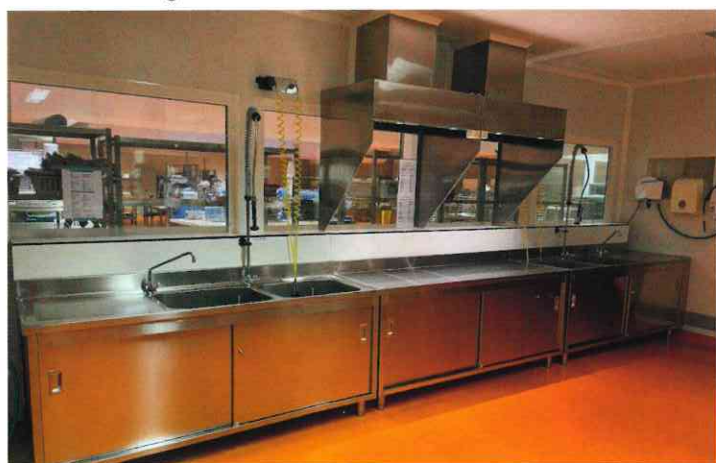
Zone de tri-lavage
