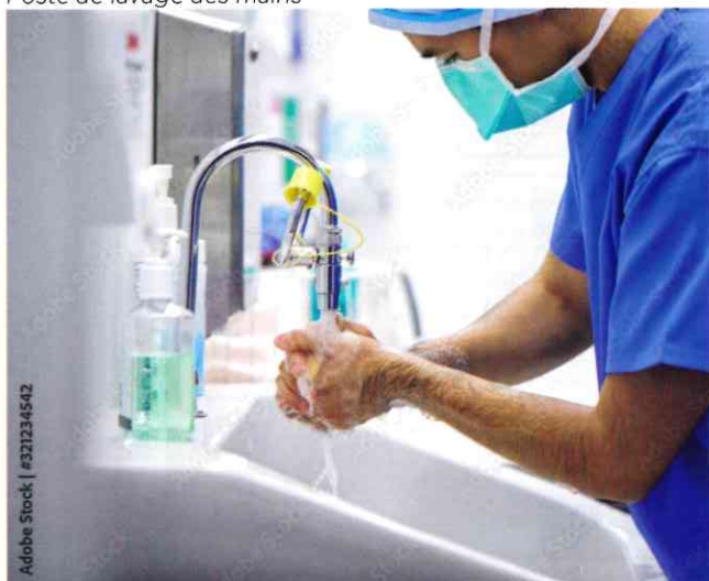
Poste de lavage des mains
